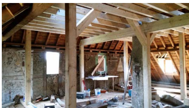
Speicherausbau im Schullandheim
